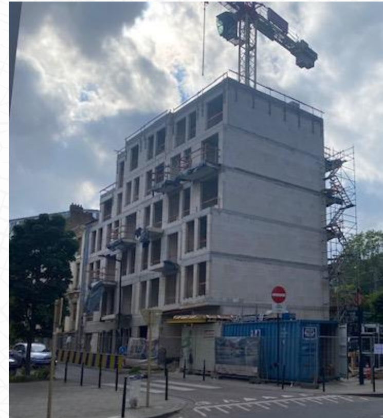
De Pascalestraat 62 tot 64, de dreiging van onteigening heeft de uitvoering van een bouwproject voor nieuwe woningen en winkels mogelijk gemaakt
